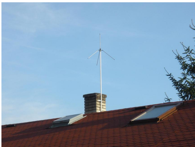
Obr. 8. GP anténa se 3 -mi radiálami umístěna na střeše domu
